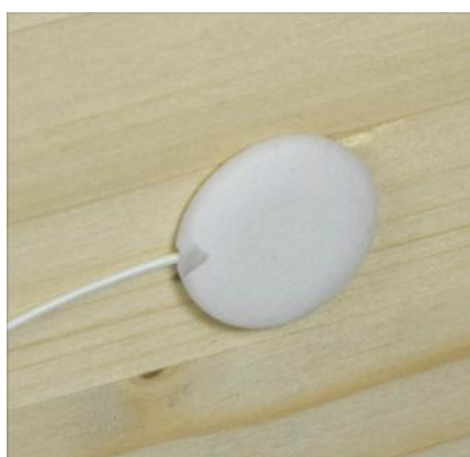
3 Monter le capuchon en orientant la sortie dans la position souhaitée (ne pas coincer le câble). Coller le capuchon si nécessaire.
